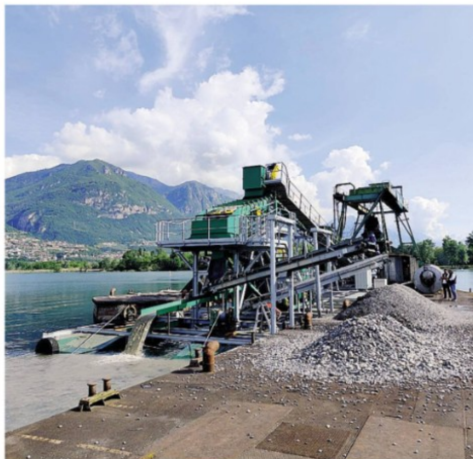
Gli imponenti macchinari posizionati a Pizzo per l'escavazione del fondale
